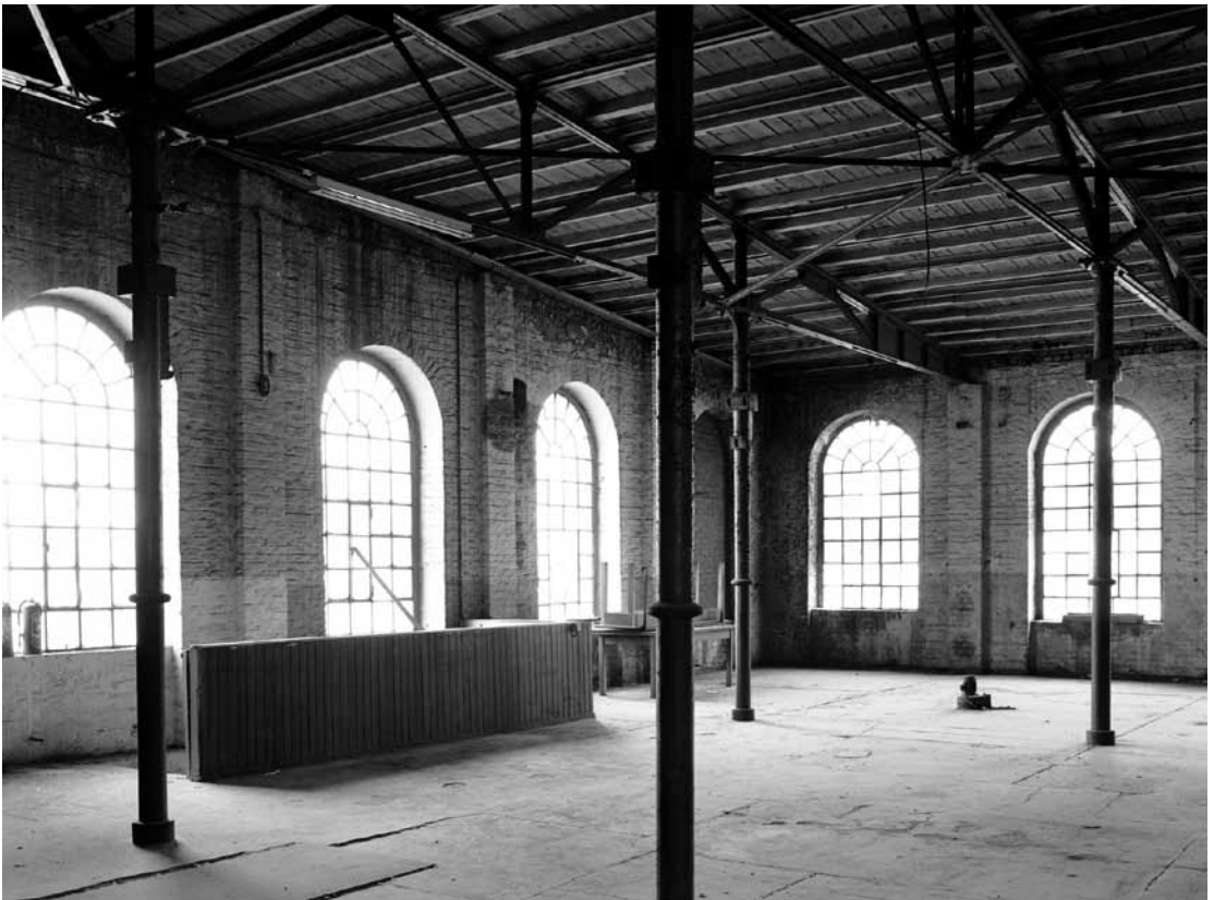
8: Frühere Gummiadernfabrik von 1890, später Drahtzug- und Stangenfabrik. Innenkonstruktion mit Gusseisenstützen. Foto: Jürgen Gregori, 2005.
