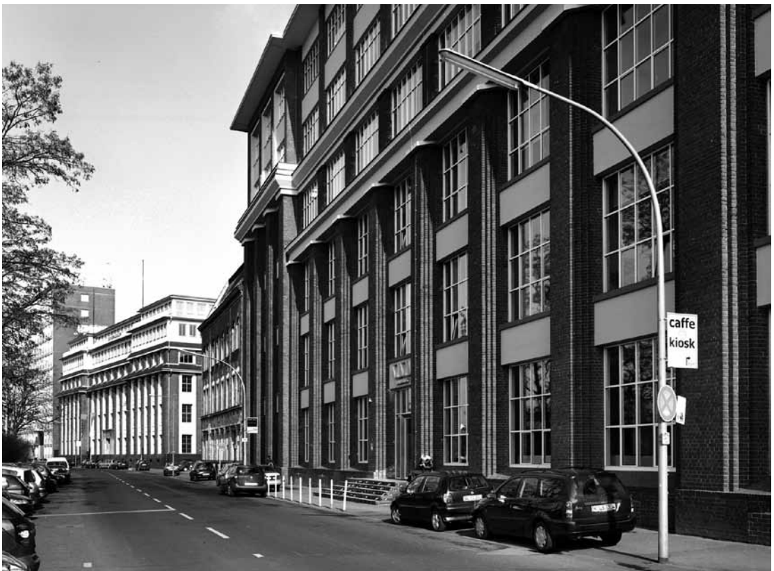
10: Kabelfabrik 1, Direktion und Hauptverwaltung. Foto: Jürgen Gregori, 2005.
