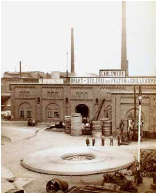
6: Fertig gestelltes Drahtseil vor dem Gründungsbau. Foto um 1890. RWWA, Bestand 11, B 3ba Nr. 1-19.
